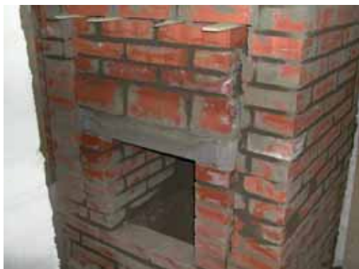
煉瓦積みの訓練
