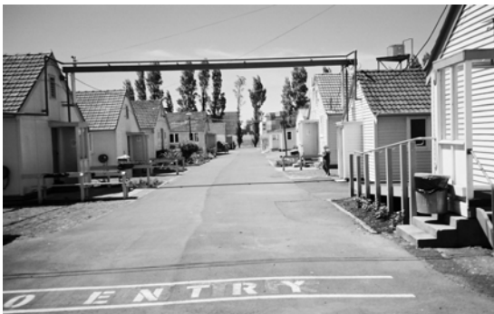
マンガレ難民定住センター・居住棟
